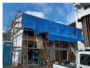
▲ 公民館前に建設中の集合住宅
