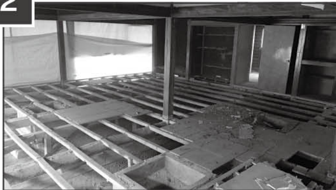
基礎から補強を行います。
