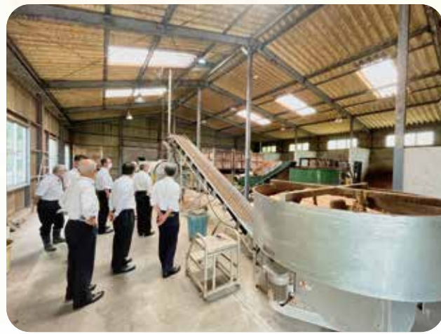
▲ 平成13年に建設し、老朽化が進む施設 (小菅村林業廃棄物処理施設)
