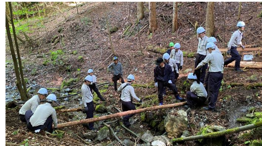
土木新入社員研修 水道管理路の保全
