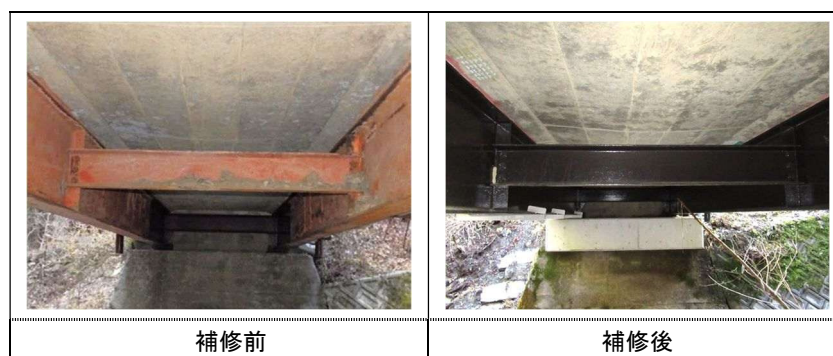
写真 1.1 補修状況写真 (No. 19_01031 鋼部材塗装塗替え)
