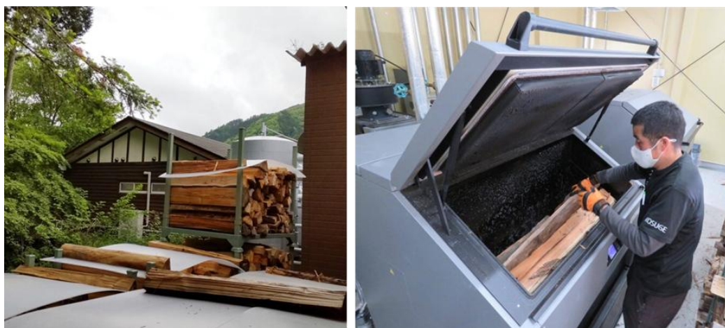
図 3-32 村内温浴施設『小菅の湯』に設置された薪ボイラー
